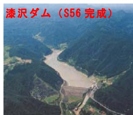
漆沢ダム (S56 完成) 宮城県 (供用中)
